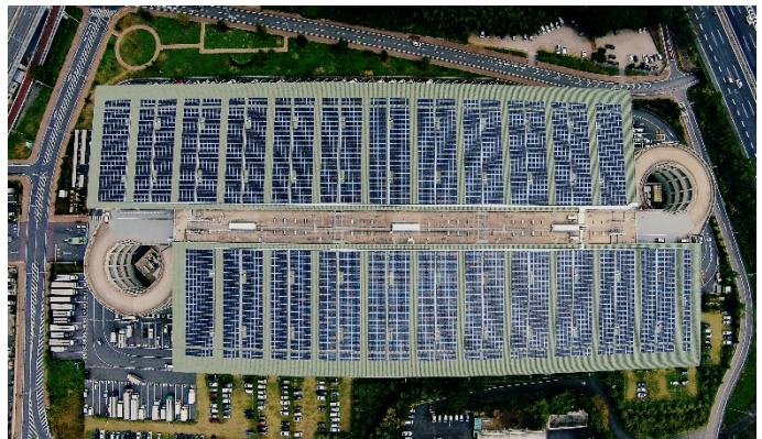
真上から見た発電所
